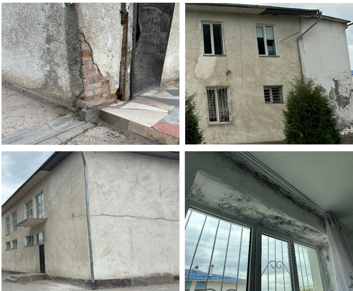
Рисунок 19: Предпроектное состояние блока А школы № 92
