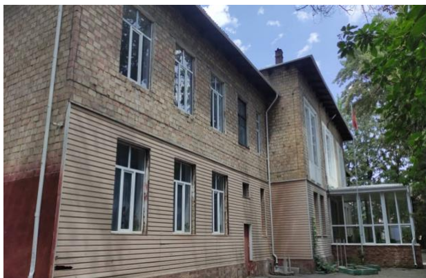
Рисунок 4: Фасад блока А школы № 16
