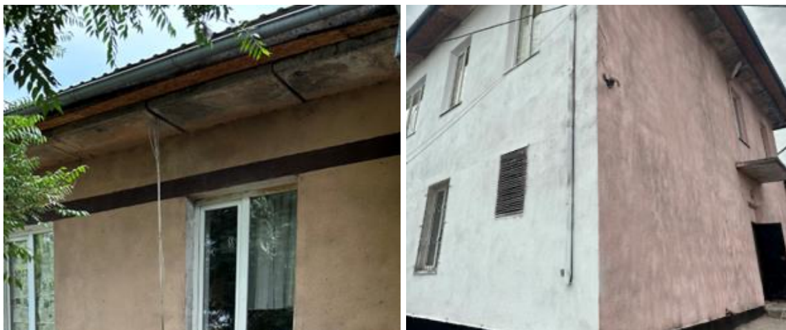
Рисунок 24: Предпроектное состояние блока А школы № 108
