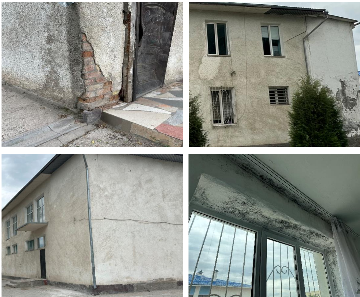
Рисунок 19: Предпроектное состояние блока А школы № 92
