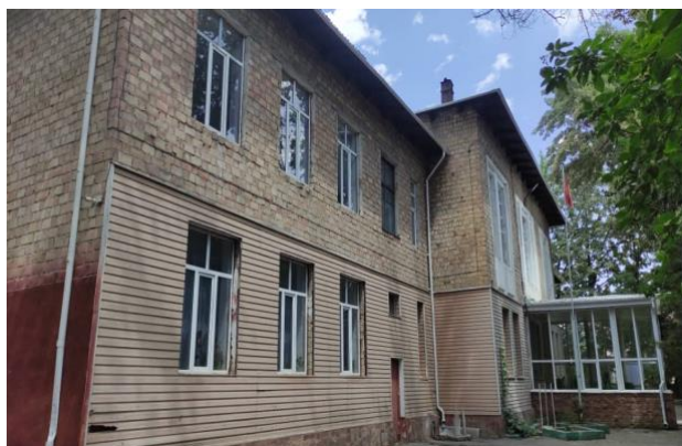
Рисунок 4: Фасад блока А школы № 16
